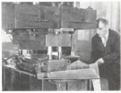
L'ingegnere G. B. Savatino dell'Ufficio tecnico del Mecovisio assicura l'operazione di smontaggio della palette del 5° stadio montate al rotore di bassa pressione di una turbina - Ansaldo - S.E.Co. - da 11.000 CV.
